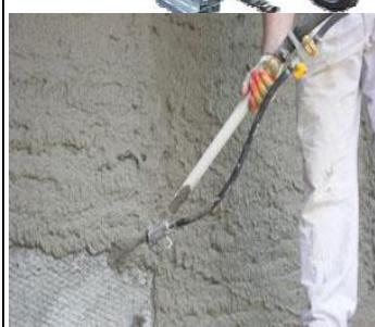
Ручное нанесение цементного обрызга Baumit Spritz: 40 кг сухой смеси Baumit Spritz засыпать в емкость к 7,5 литрам чистой воды. Замешивать в бетономешалке или с помощью строительного миксера до образования однородной массы без
