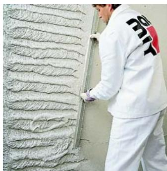
После 1,5-2 часов технологического перерыва поверхность торцуется, слегка увлажняется и затирается штукатурной тёркой.
